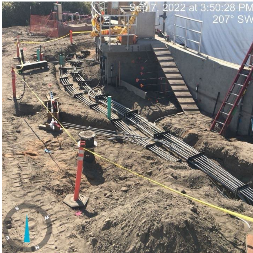
Electrical Conduit Under SC2 Slab_2022.09.07
